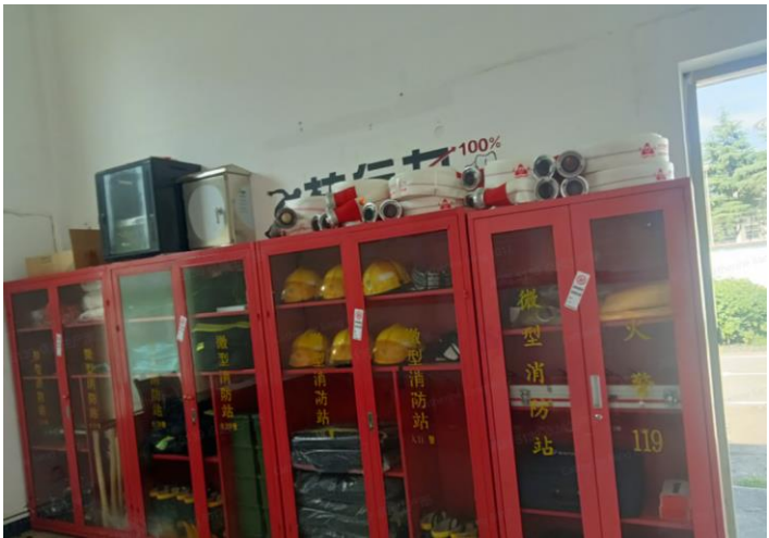
上海抚佳微型消防站
